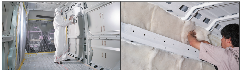
ダブル断熱施工 (断熱セラミック塗装+サーモウール)
